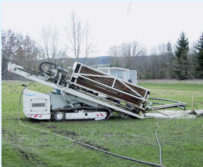
BOHRVERFAHREN: zum Unterqueren einer Straße Bild 3
