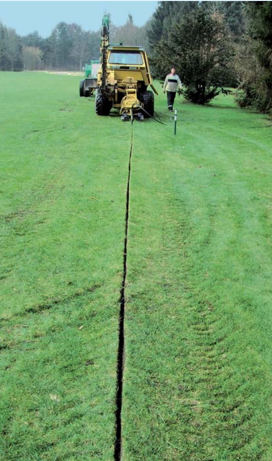
Einpflügen einer Druckrohrleitung
